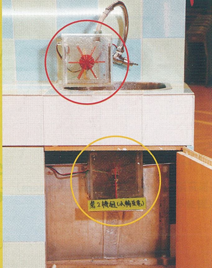
設計共分上下兩個發電機組，第一發電機組（紅圈）主要用開水喉流出的清水帶動扇葉發電；而第二發電機組（黃圈）就靠流走的污水帶動扇葉發電。
